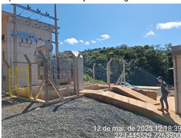
Figura 11: Bacia de contenção e caixa separadora da subestação de energia.
