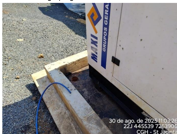
Figura 10: Bacia de contenção e CSAO do grupo gerador.
