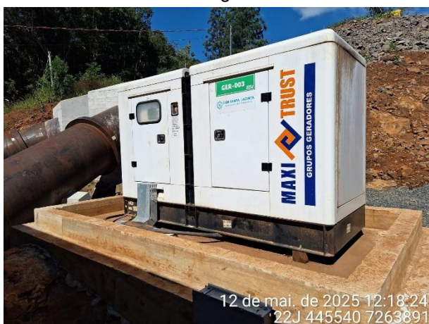
Figura 10: Bacia de contenção e CSAO do grupo gerador.
