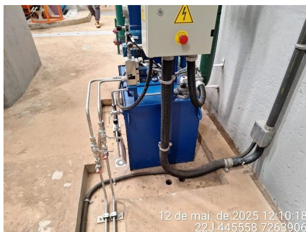
Figura 8: Piso impermeável e bacias de contenção em equipamentos.
