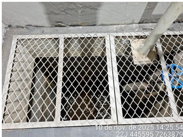
Figura 9: Poço de drenagem no interior da casa de força.
