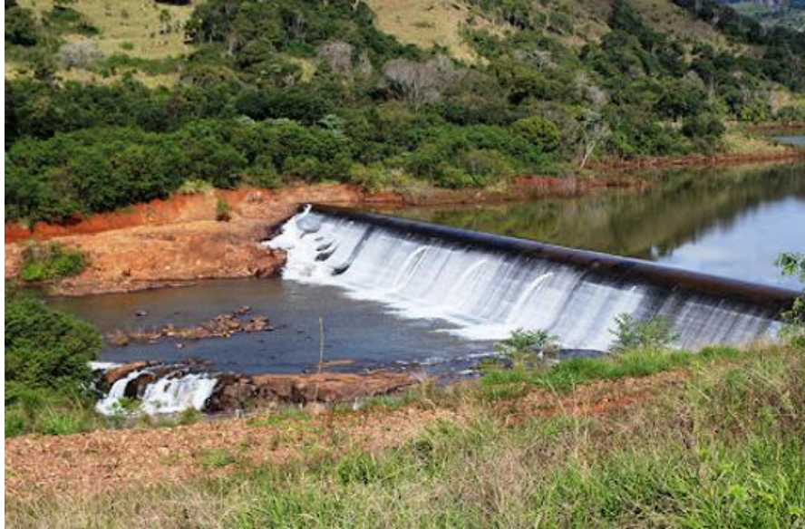
Figura 31: Soleira vertente da PCH Itaguaçu, localizada próxima à foz no rio Pitanga.
