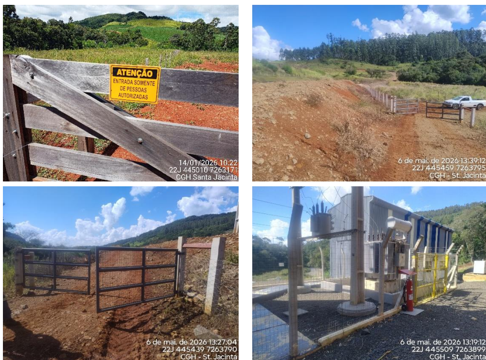
Figura 15: Portões e cercamento de algumas áreas do empreendimento.
