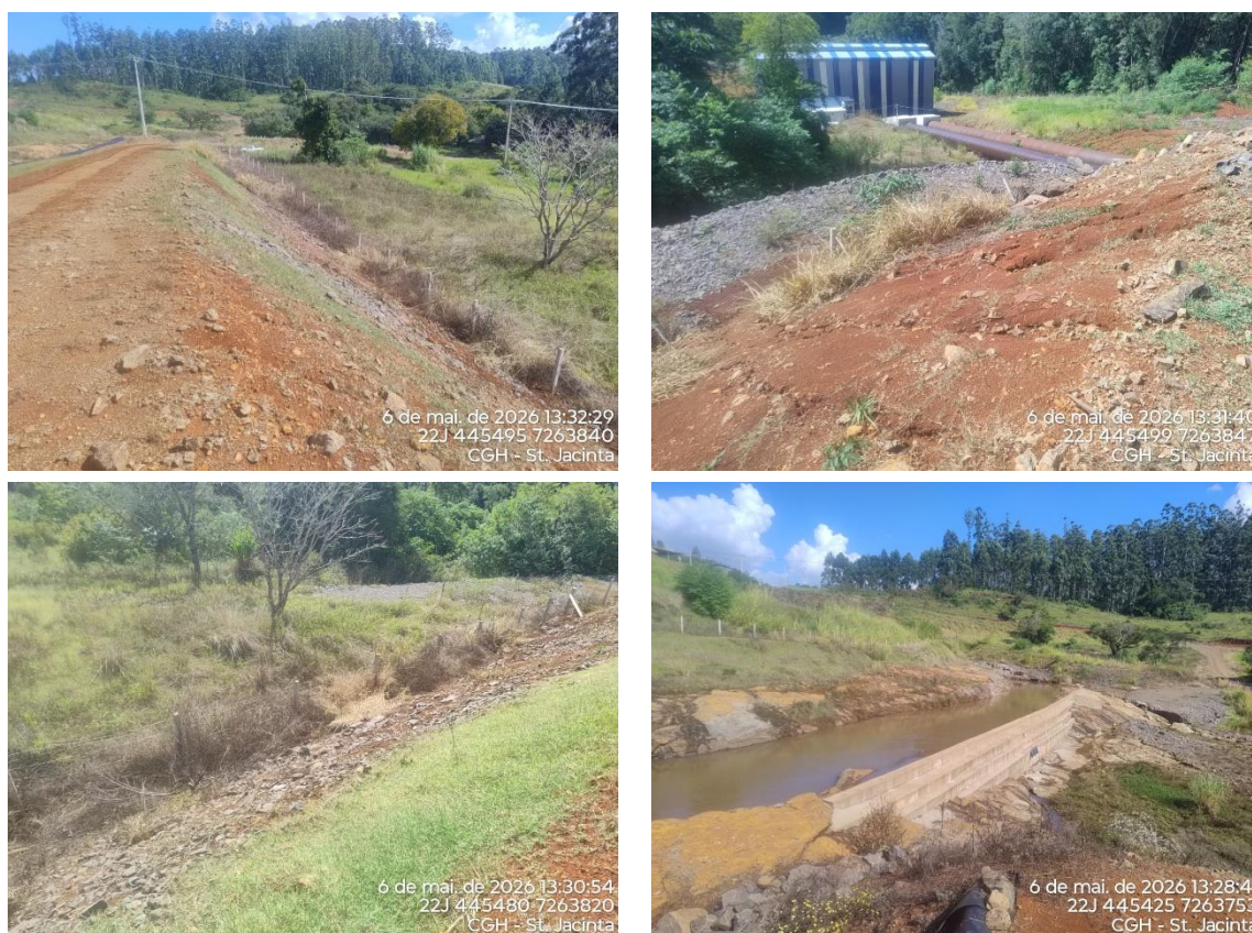
Figura 7: Condição dos taludes no entorno do canal adutor e da câmara de carga.
