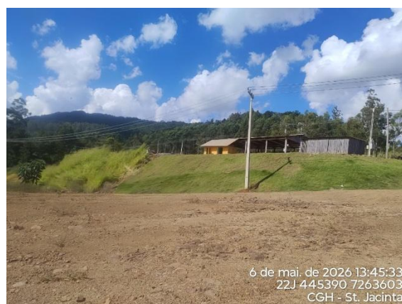
Figura 6: Taludes protegidos com grama e hidrossemeadura.
