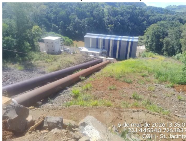
Conduto forçado e casa de força
